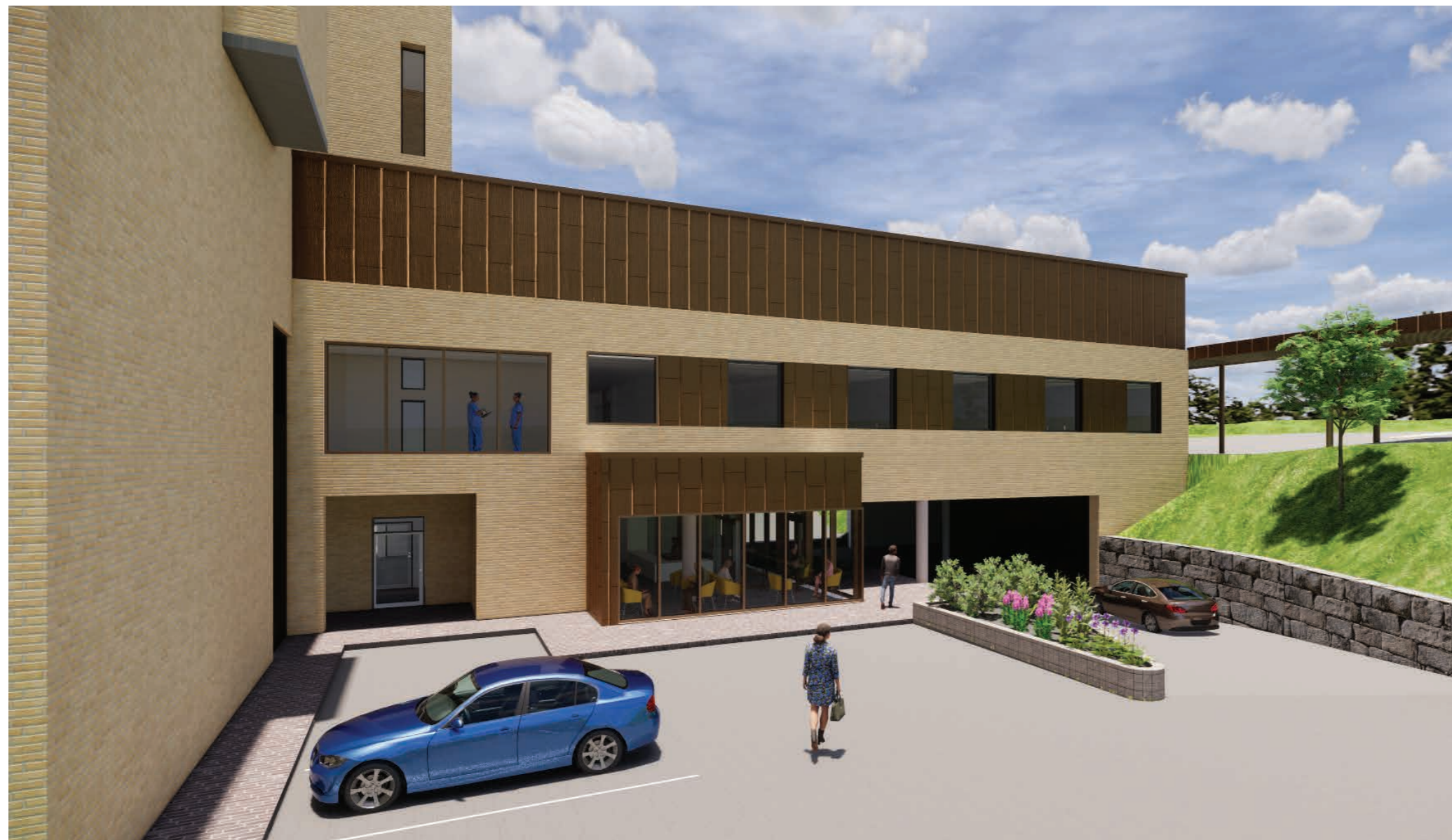
Akuttpoliklinikk sett fra vest
