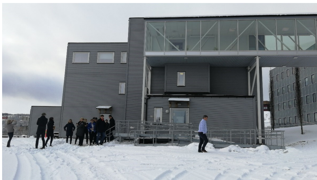
Figur 5-7 Modulbygg fra UNN
